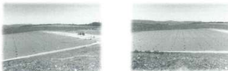
New Cell at Karwyderskraal Landfill Site
