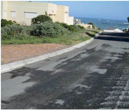
Storm water- Pearly Beach and Baardskeerdersbos
